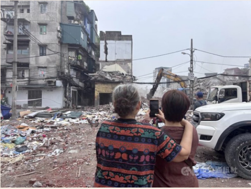
河內民眾圍觀公寓拆除工程。(圖片來源:中央社)
