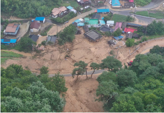
南韓慶尚南道山清郡民宅被土石流沖毀。
